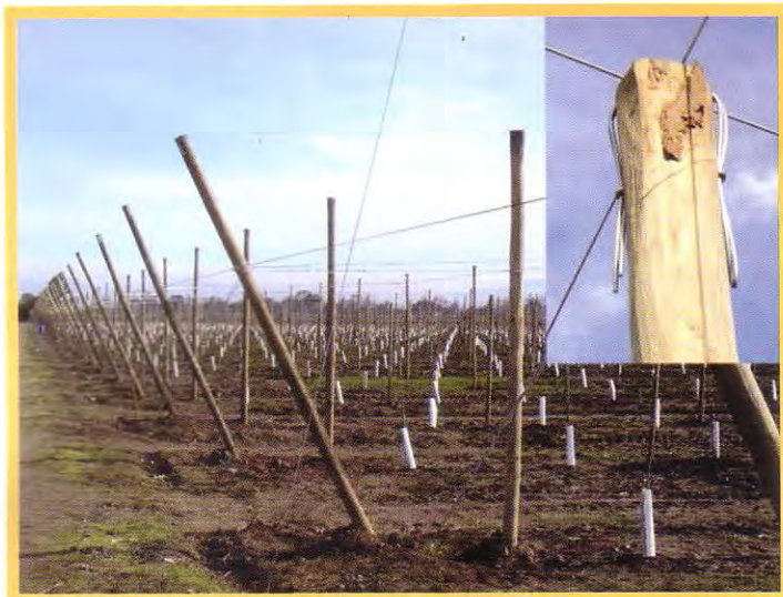
Foto 11.- Detalles de la estructura. Posición de cabezal en relación al central y fijado de alambre superior sobre los centrales. Trabado de alambre superior sobre el cabezal.
