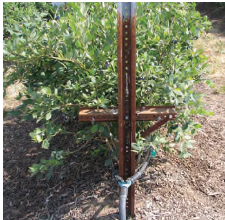
Foto 17. Estructura metálica con cruceta y doble alambre.
