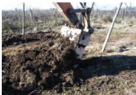
Foto 8A, 8B y 8C: Garra penetra completamente, siendo capaz de mezclar el suelo.
