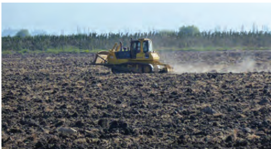
Foto 6: Bulldozer D8, trabajando a 1 mt de profundidad.
