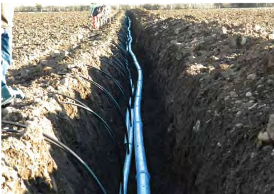
Foto 5. Instalación de riego tecnificado.
