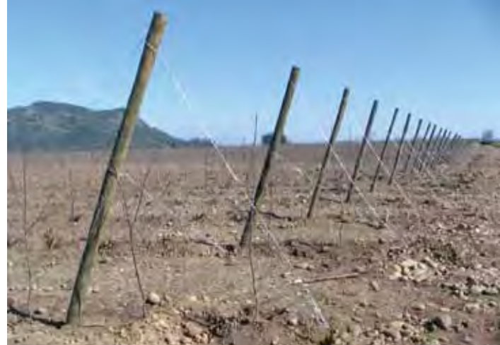
Foto 9. Instalación de Estructura de Soporte.
