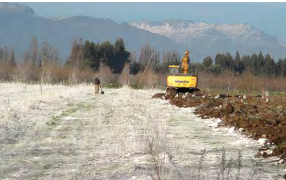
Foto 3. Incorporación de enmienda cálcica junto con la preparación de suelo.
