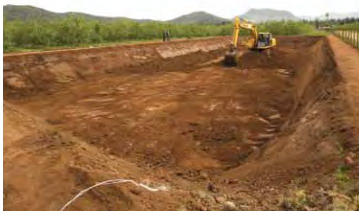
Foto 8. Construcción de Tranque para acumulación de agua.
