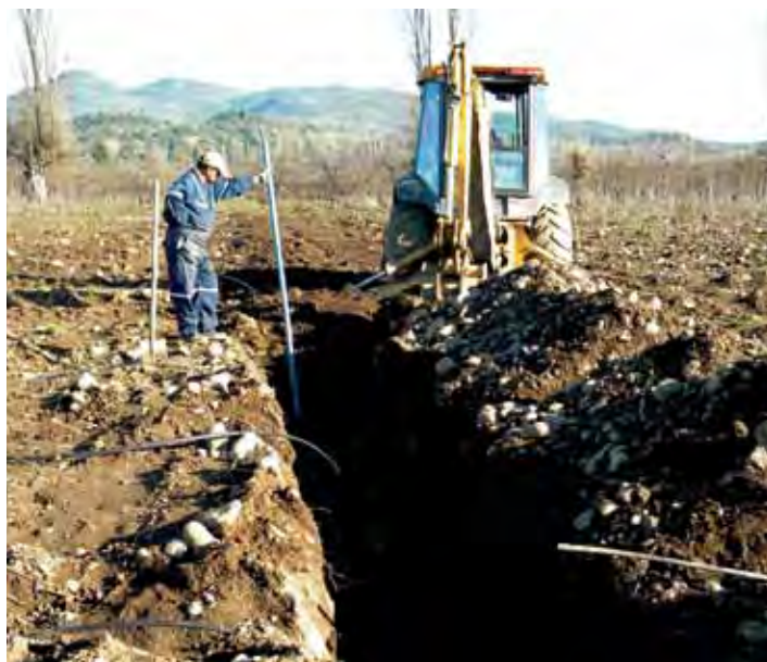
FIGURA 2. Instalación del sistema de riego y estructura.
