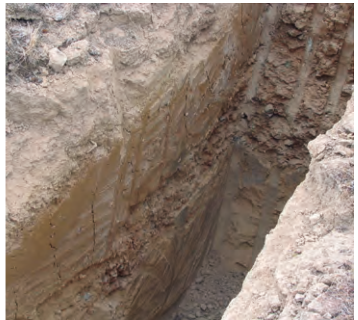
FOTO 4 Calicata a profundidad de 3mt en suelo limoso
