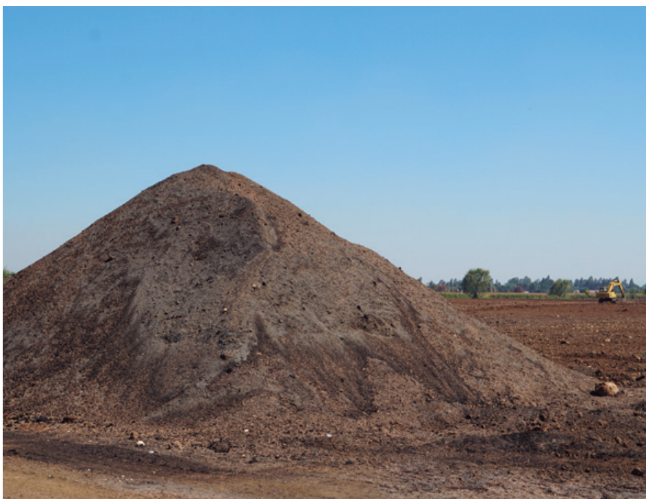
Foto 3; Aplicación de enmiendas, para mejorar las condiciones físico y químicas del suelo
