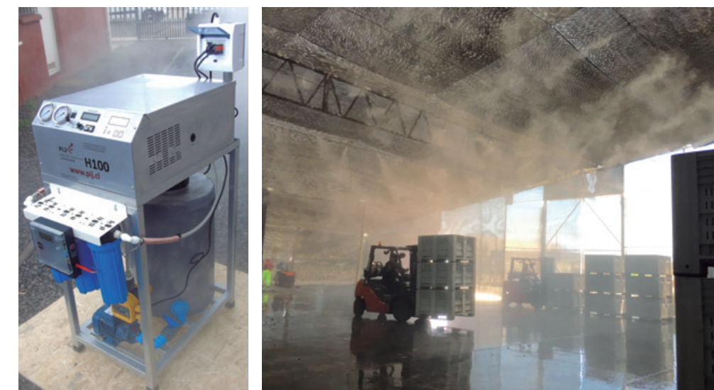
Figura 1. Equipo desarrollado por Proyectos Industriales Johnson para generar las condiciones de humidificación óptimas (izquierda). Sistema humidificador en recepción en central de embalaje (derecha).
