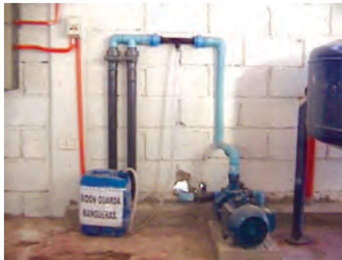
Foto 7 Equipo inyector de ácido sulfúrico
