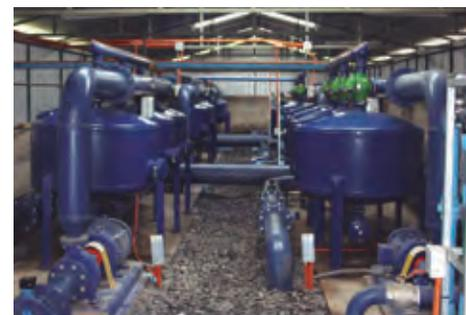
**FOTO 6.** Este es un modelo de caseta ideal, espaciosa, ventilada e iluminada, se concentra los equipos en un solo punto lo que facilita la operación y supervisión de estos.
