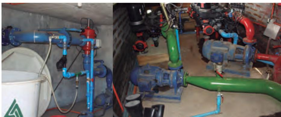
**FOTO 5.** Casetas estrechas, la de la izquierda presentará un problema al querer limpiar o desarmar el filtro de malla producto de que el techo está muy bajo; en el caso de la derecha se observa muy estrecho el espacio para poder trabajar en cualquier mantenimiento del equipo.
