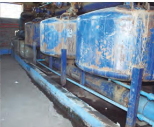
**FOTO 2.** Equipos en un mal estado, producto del descuido y poca o nula mantención.
