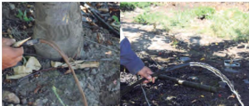
FOTO 7. Izquierda se ve claramente la mala calidad del agua que está llegando a los emisores, con el evidente peligro de producir un taponamiento. Derecha se ve un agua muy limpia al hacer el descole.
