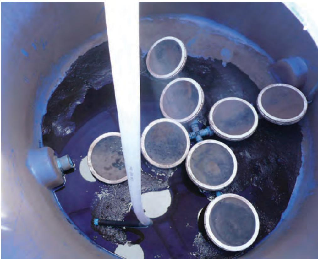
**FOTO 3.** Sistema agitador con inyección de aire.
