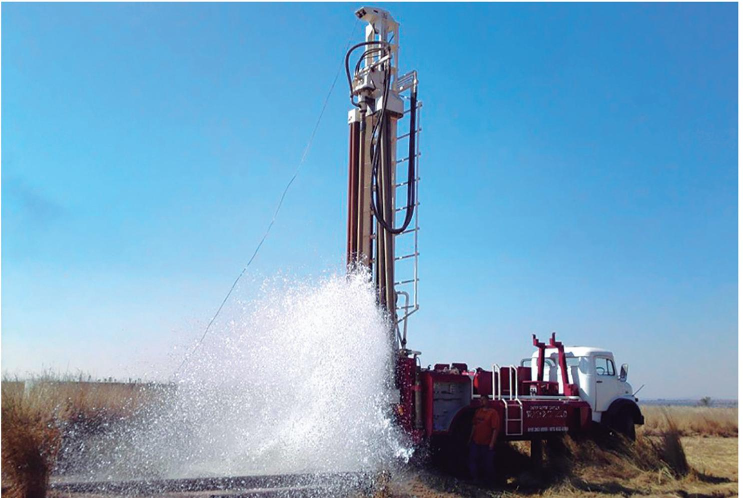
**Figura 1.** Faenas de perforación de un pozo profundo.
