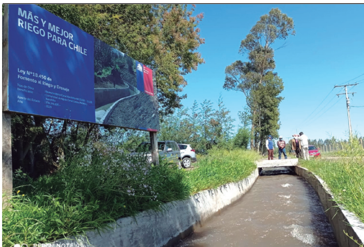
Figura 2. Comunidad de aguas de San Carlos acondicionó tres kilómetros de canales con bonificaciones de la Ley de Riego, región Del Maule.
